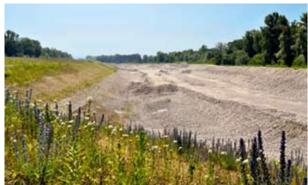
Projekt „Hochwasserrückhalteraum Weil-Breisach“
