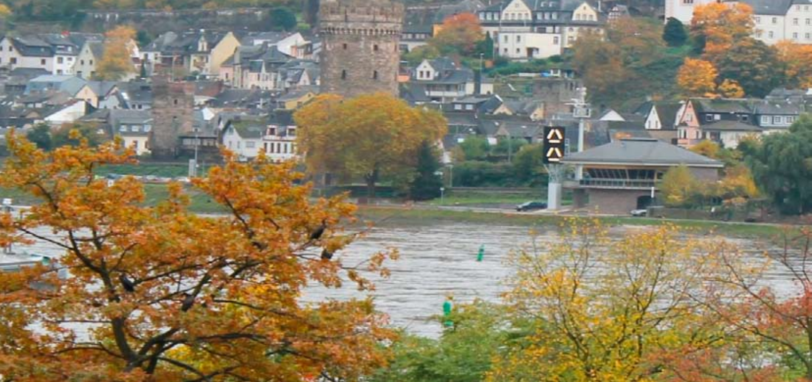
Revierzentrale Oberwesel mit Lichtsignalanlage
