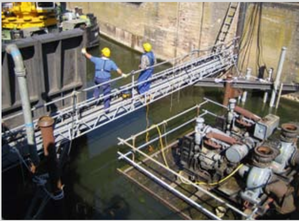
Stellen eines Revisionsverschlusses
