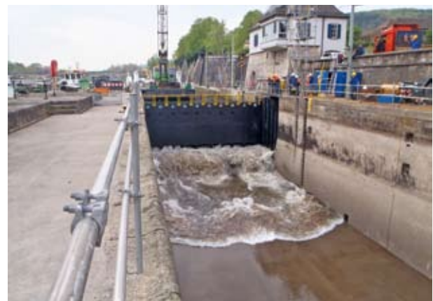
Eingebautes Oberhaupttor Schleuse Würzburg beim Fluten
