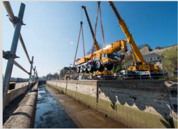
Autokran wird in die Schleusenammer gehoben
