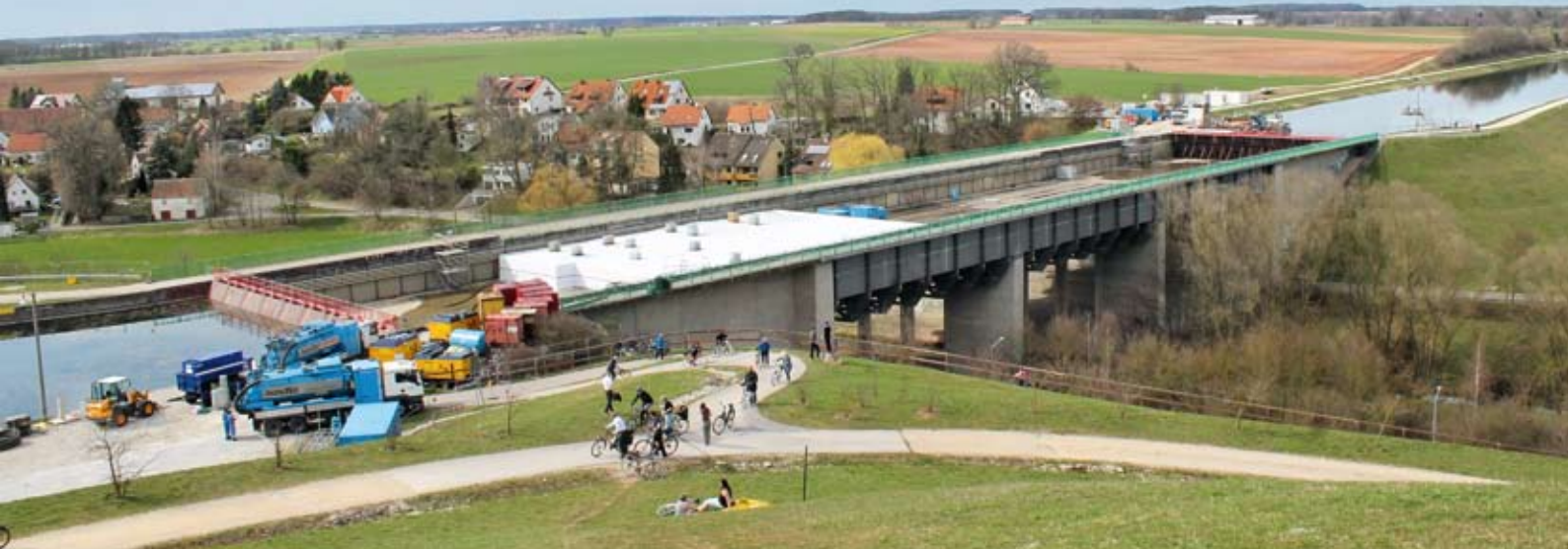
Korrosionsschutzarbeiten Einhausung Trogboden
