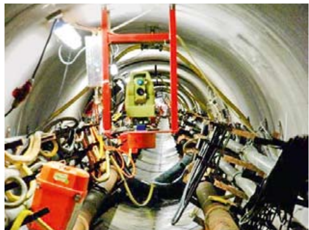
Dükerbau Schleusenanlage Brunsbüttel
