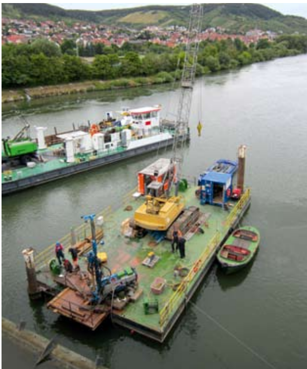
Baugrundbohrungen an der Wehranlage Erlabrunn
