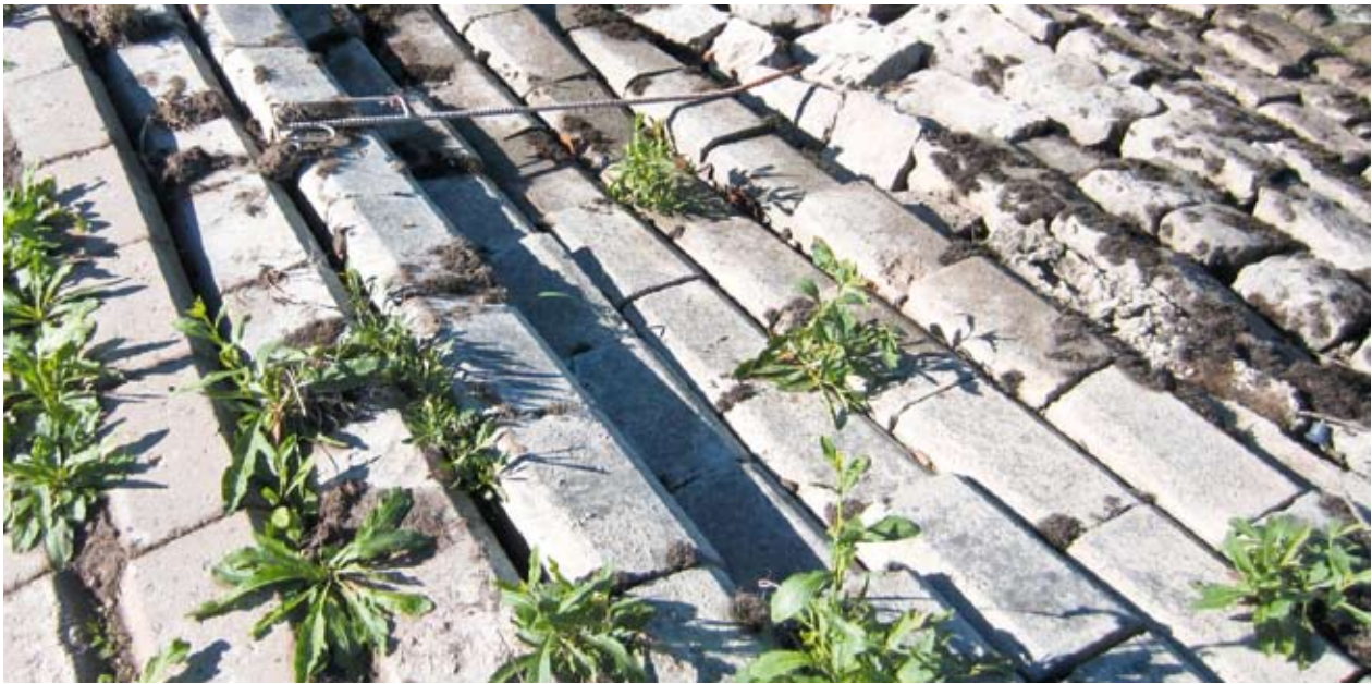
Beschädigtes Pflasterdeckwerk
