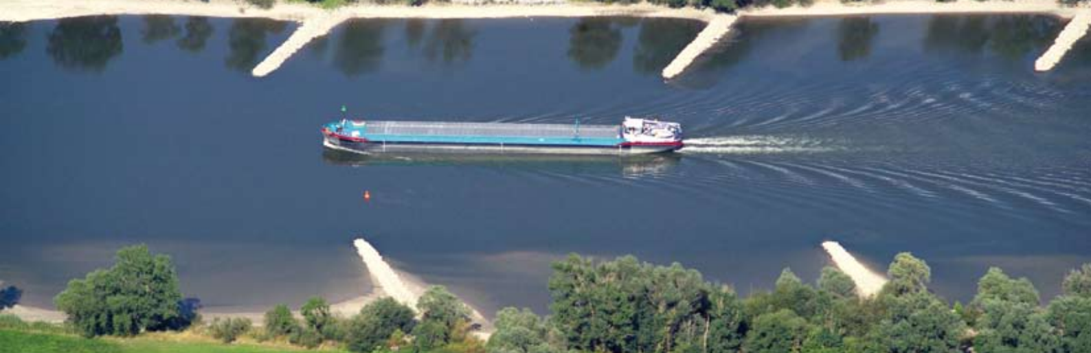
Buhnen als flussregelnde Maßnahmen
