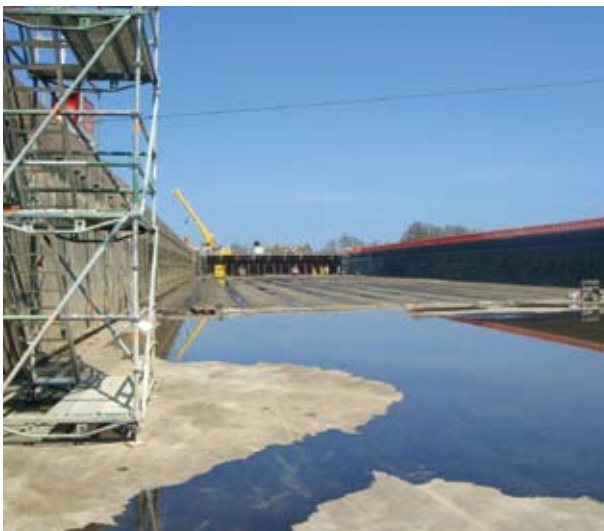
Trockengelegte Kanaltrögbrücke Zenn
