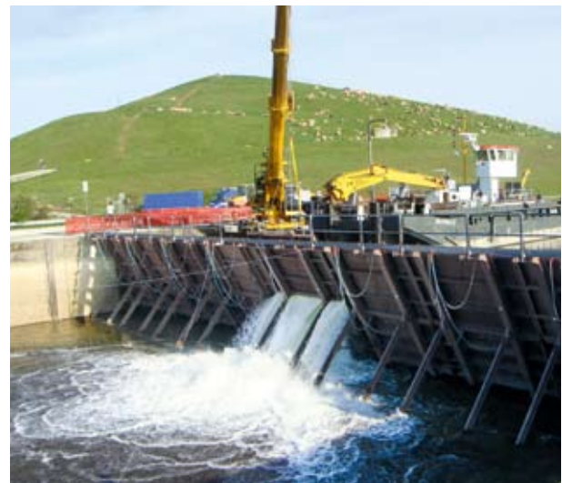
Flutung der Kanaltrögbrücke Zenn
