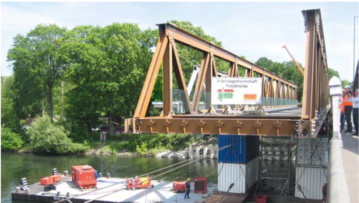
Einbau einer Behelfsbrücke an der Freybrücke
