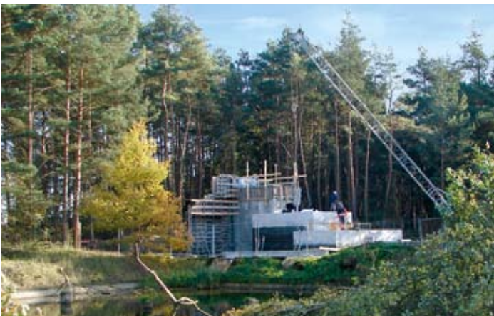
Blick auf die Baustelle
