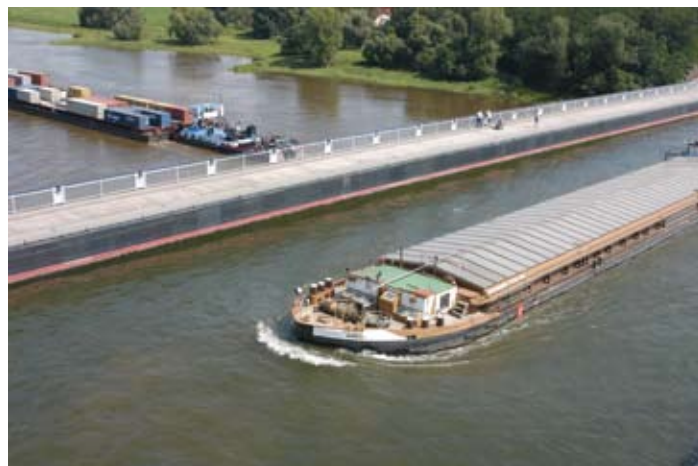
Containerschifffahrt auf der Elbe, Wasserstraßenkreuz Magdeburg
