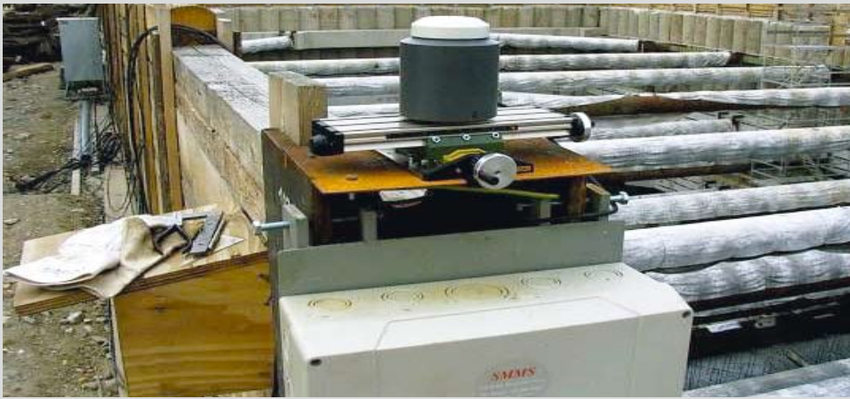
Satellitenantenne mit Spezialaufnahme zur Überwachung der Baugrubensicherung
