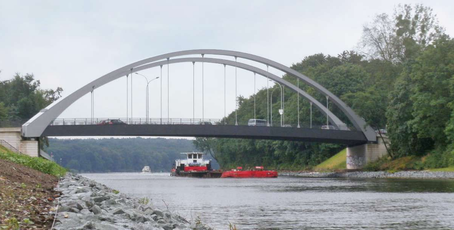
Ausgebauter Nedlitzer Durchstich im Sacrow-Paretzer Kanal
