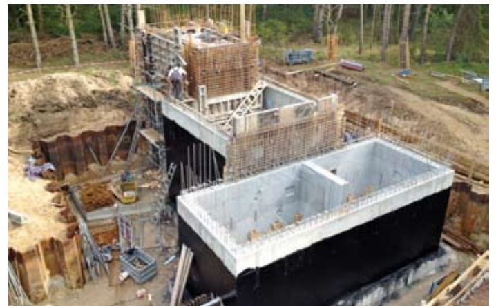
Kammern im Bau
