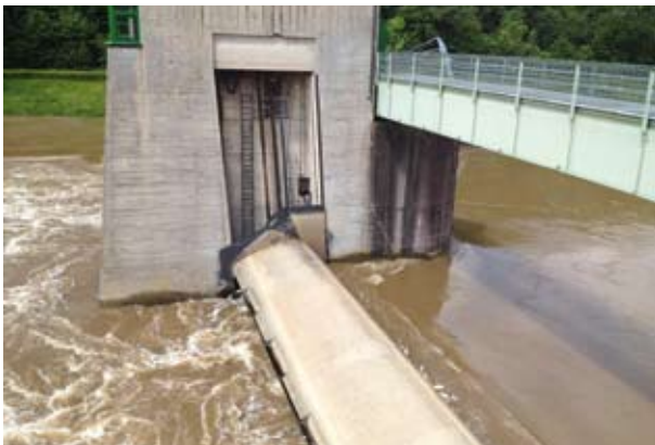
Wasserabfuhr an der Wehranlage Rothenfels
