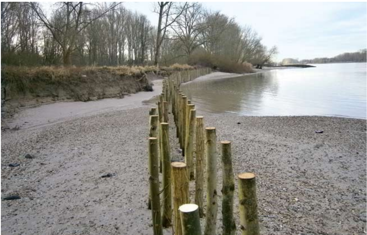
Weidenpfähle, die mit Ästen gefüllt werden
