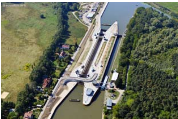
Neubau der 2. Schleuse Wusterwitz
