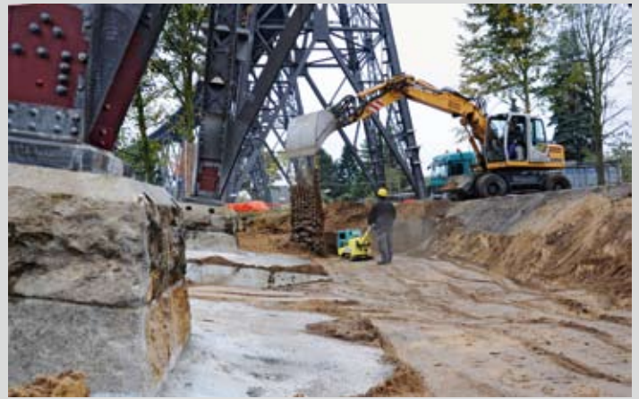
Arbeiten an den Brückenfundamenten
