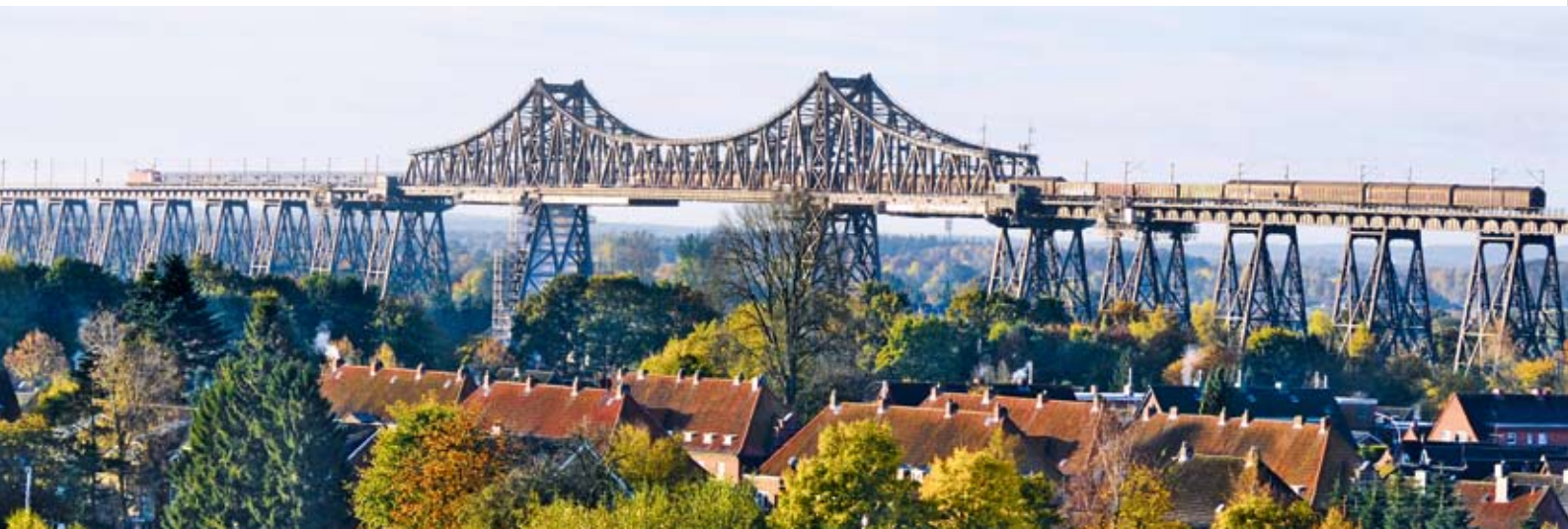
Panoramabild: Eisenbahnhochbrücke Rendsburg
