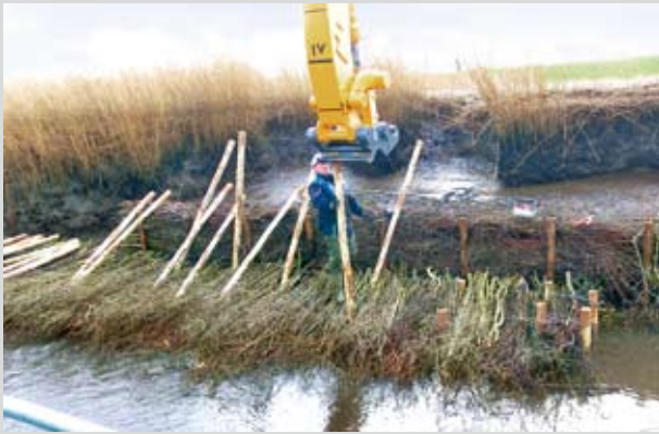
Herstellung der technisch-biologischen Ufersicherung
