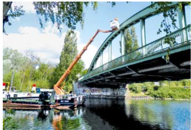
Brückenuntersuchungsschiff mit Hubarbeitsbühne
