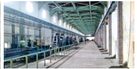
Überbau Wehr Kachlet innen
