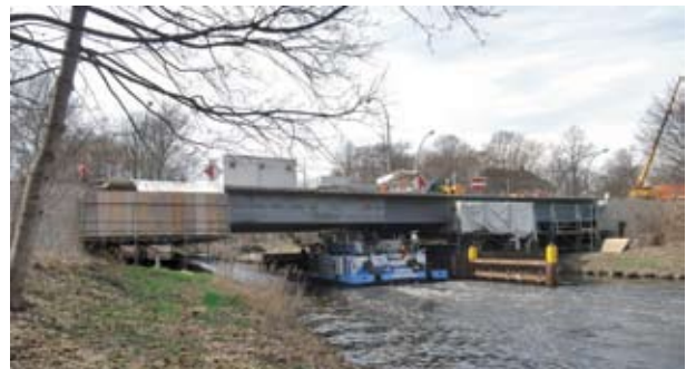
Korrosionsschutzarbeiten über Wasser
