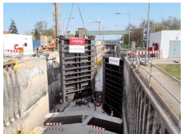
Einbau Schleusentor am Mittelhaupt
