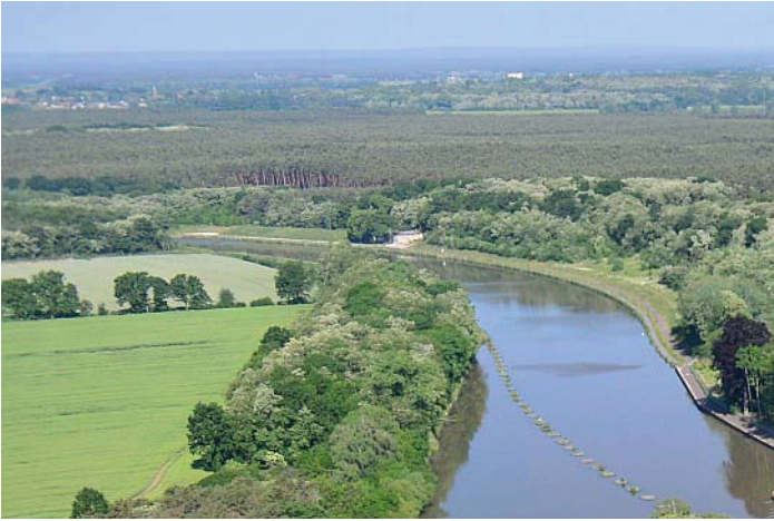
Blick auf die Baggerarbeiten zur Herstellung der neuen Fahrt
