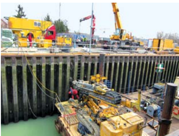
Ankerbohrungen in der Spundwand 2014
