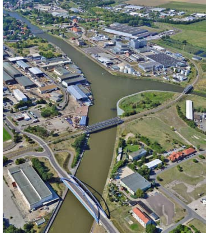
Blick Richtung Osten auf den neu erstellten Brückenknoten Genthin
