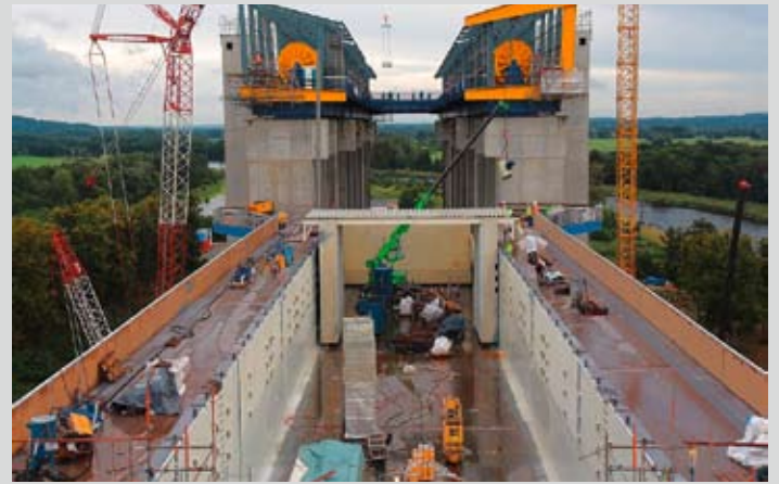
Neubau des neuen Schiffshebwerks Niederfinow
