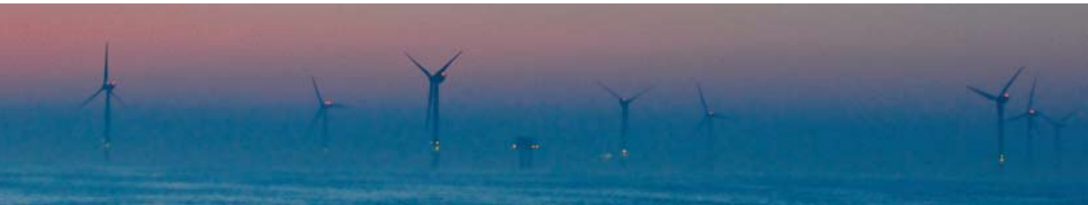
Blick auf den Offshore-Windpark „alpha ventus“
