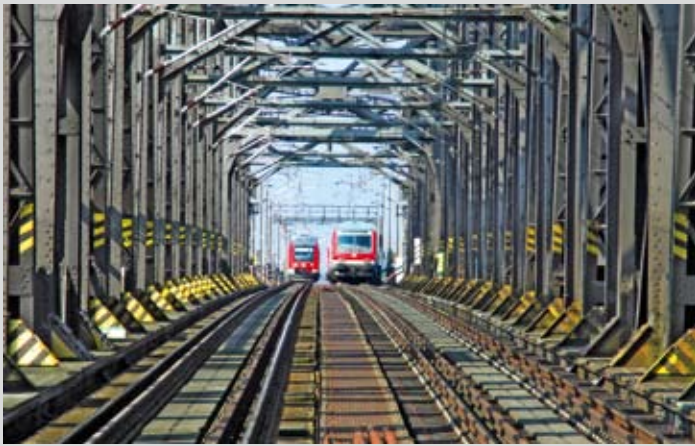
Zweigleisiger Bahnverkehr auf der Hochbrücke
