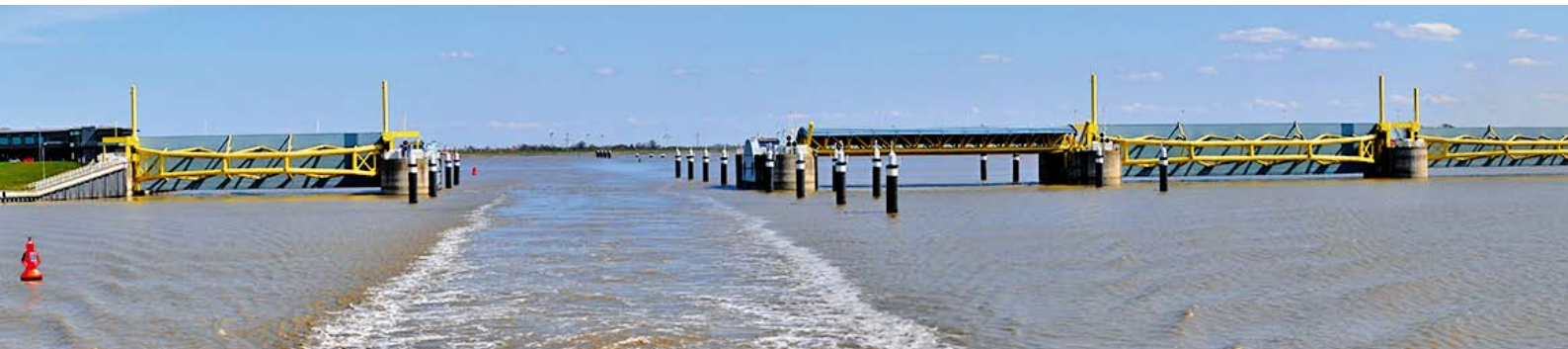
Emssperrwerk bei Tidehochwasser (Foto: Roeloffzen)
