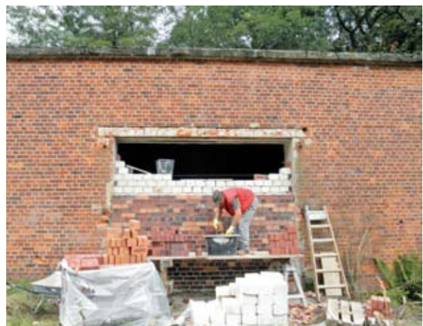
Zumauern einer Gebäudeöffnung
