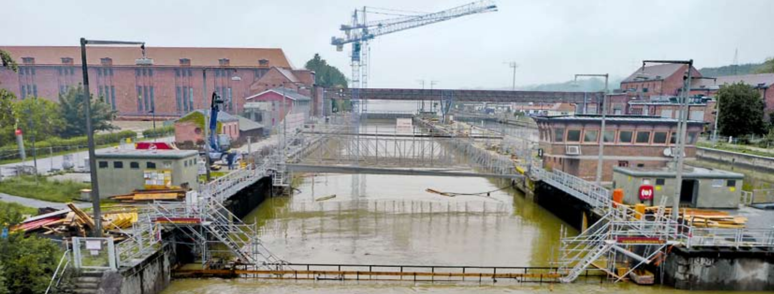
Hochwasser 2013 Schleuse Kachlet
