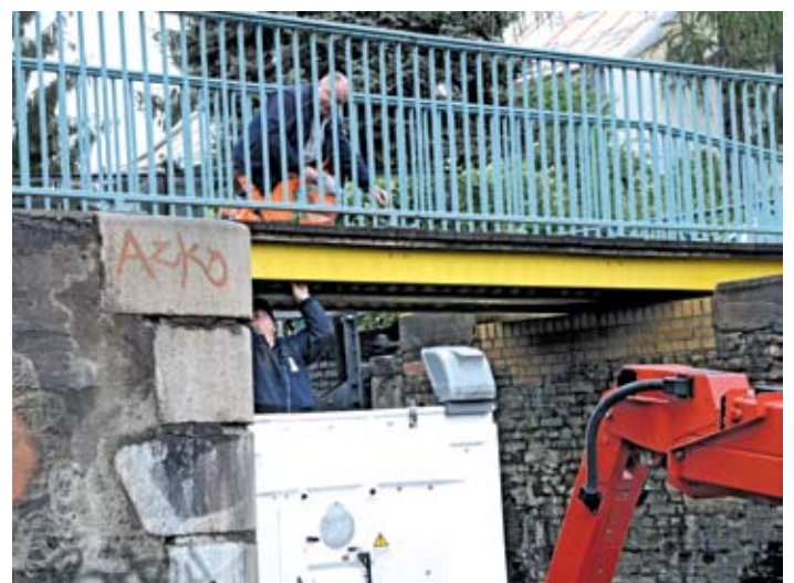
Brückenprüfer bei der Arbeit
