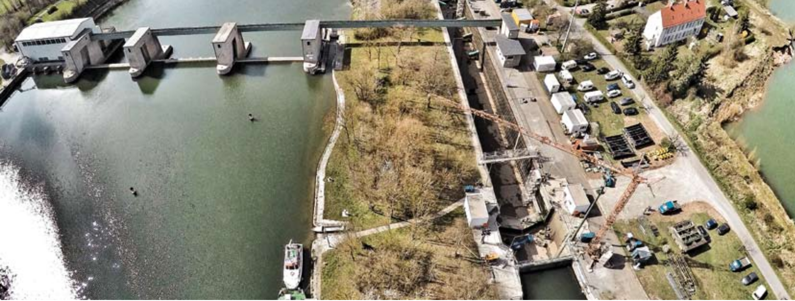
Baustelle Schleuse Dettelbach, April 2015
