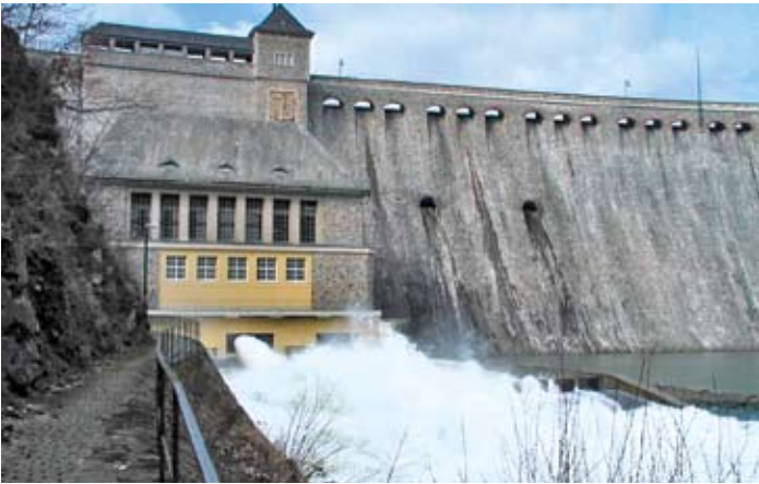
Wasserabgabe aus den Grundablassrohren der Edertalsperre
