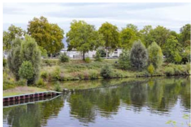
Flachwasserzone am Hochwassersperrtor Ladenburg
