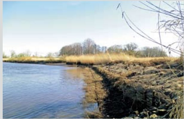
Kurz vor Fertigstellung der tech.-biolog. Ufersicherung
