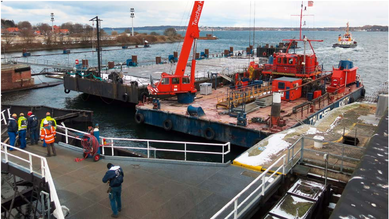
Schiebetorwechsel an der Schleuse Brunsbüttel
