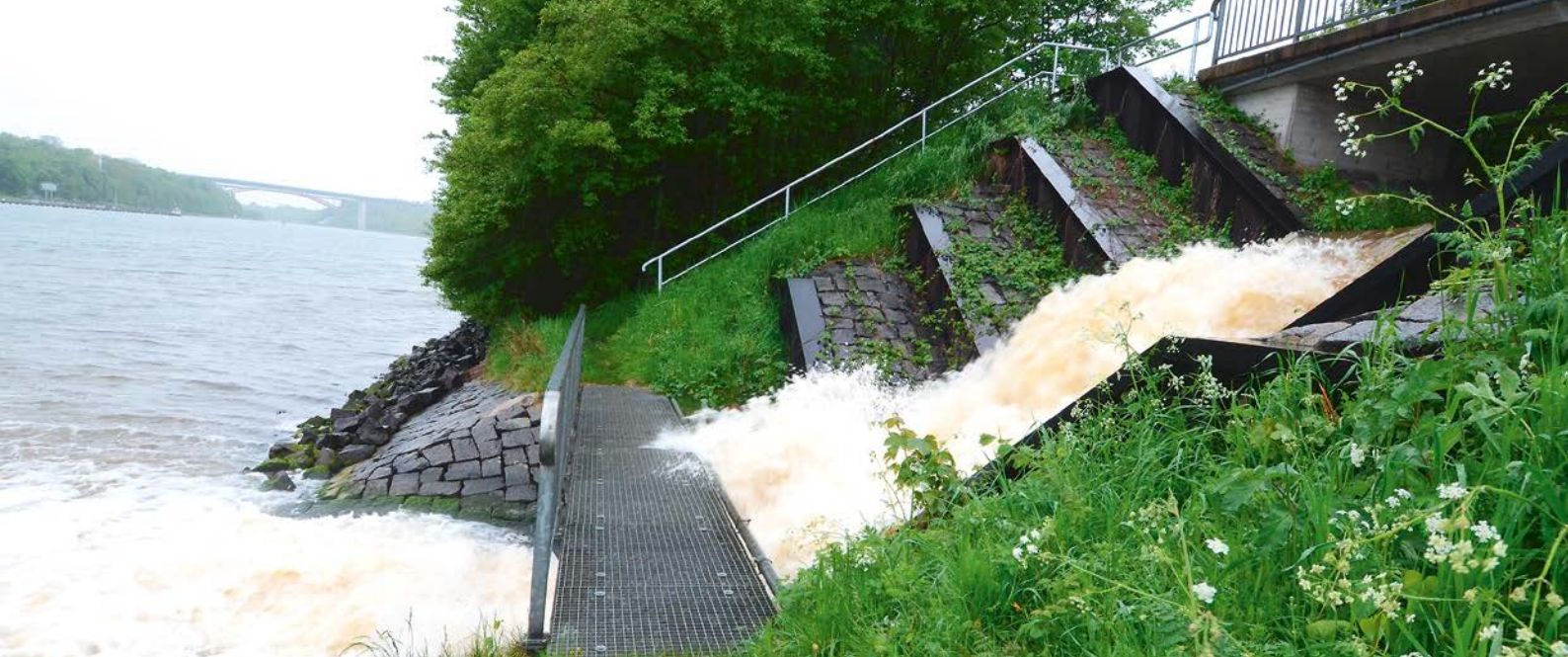
Einlaufbauwerk bei Projensdorf
